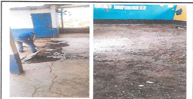
Foto 5: Sustitución de Piso Cerámico
