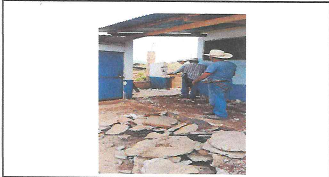
Foto 1: Sustitución de puerta.
