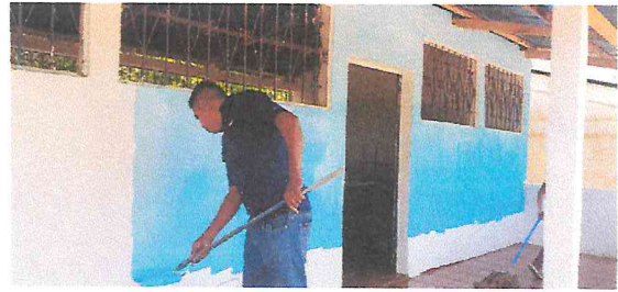
Foto 8: Pintura en muros exteriores e interiores
