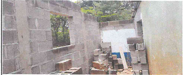
Foto 10: Construcción de cocina
