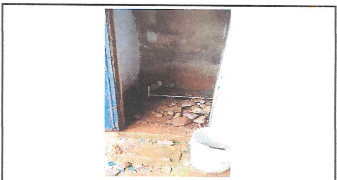
Foto 4: Sustitución de Inodoro.
